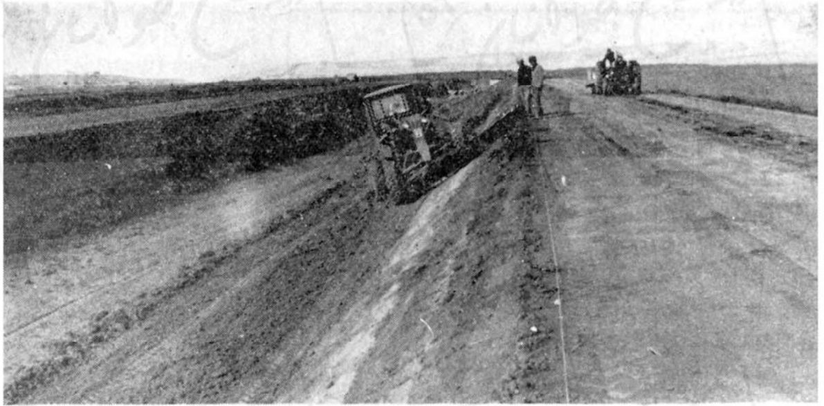
شیب بدنه کانال اصلی که با گریز رزده میشود کیلومتر ۱۰ قطعه سوم
