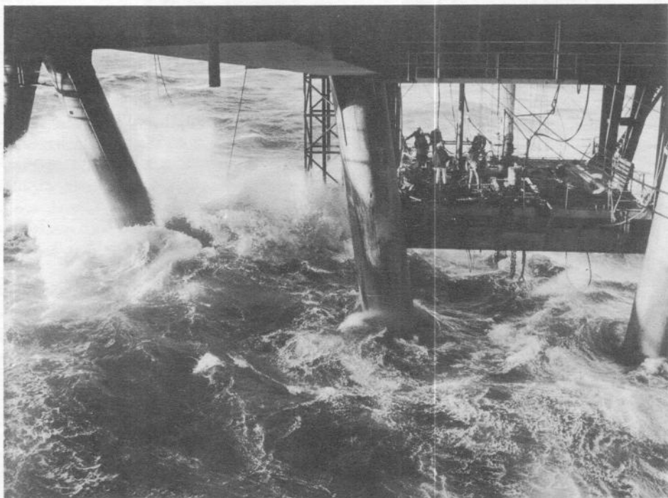
اثرات خوردندگی در قسمتهایی که در معرض حملات امواج دریا و یا جذر و مد می‌باشد بیشتر است.
