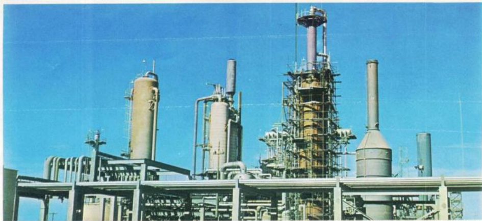
منظره‌ای از کارخانه عظیم آمونیاک سازی مجتمع شیمیایی شاهپور
