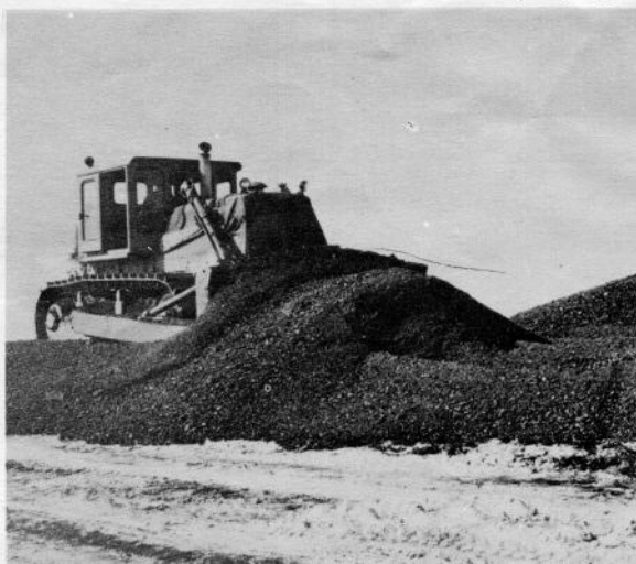
جاده سازی در توندراهای شمال آلاسکا ۴۰۰ میل جاده بار یختن قریب دو میلیون متر مکعب شن و ریگ در مدت چند ماه ساخته شد.
