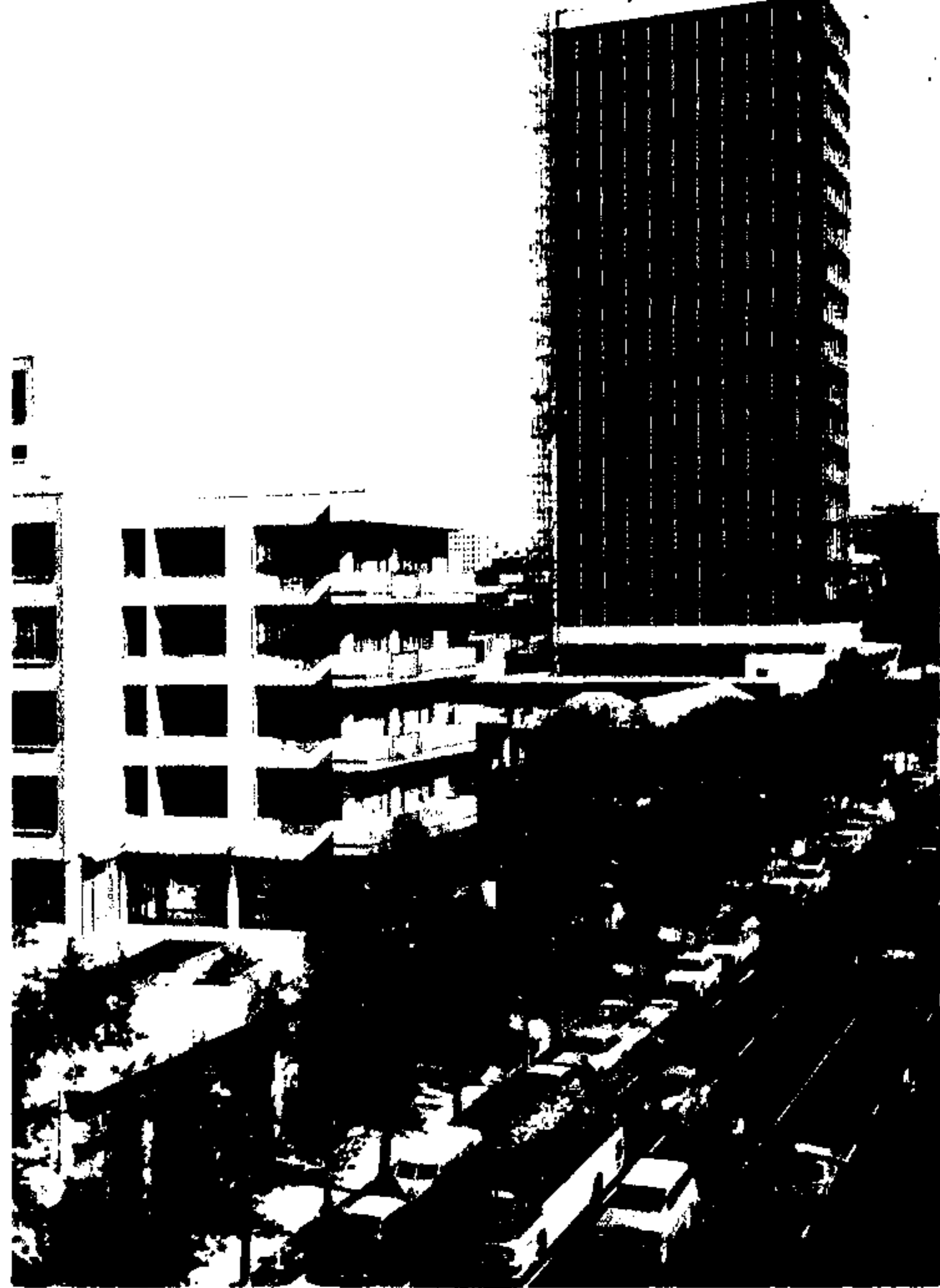
تهران ، ساختمان بانک کار
